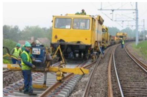
Longs Rails soudés sur traverses béton
