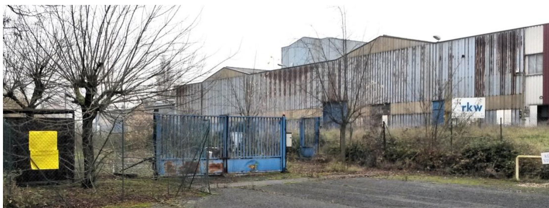
Bâtiments RKW désaffectés, à démolir
