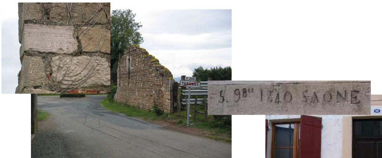
Taponas, repère de la crue de 1840,
