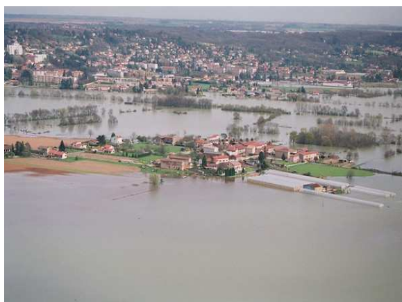
Quincieux, crue de 2001
