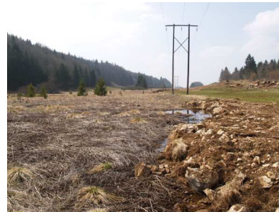
Remblaiement de zones humides
